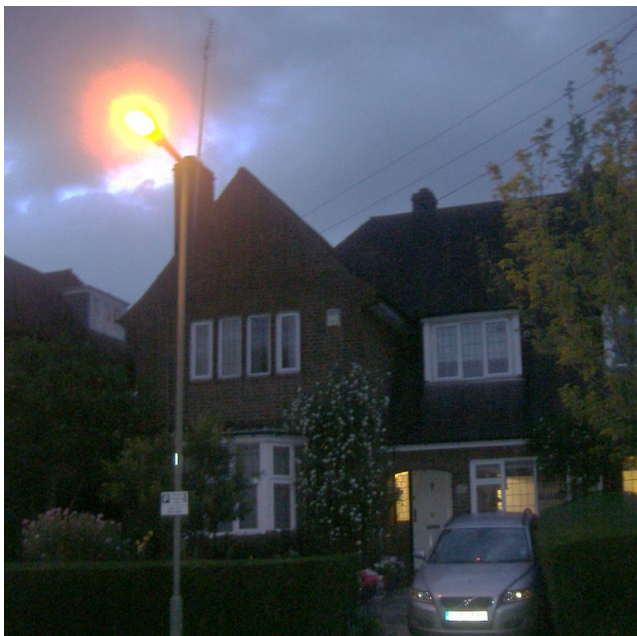
Рис. 2. В данном случае засветка в окна была уменьшена путем установки на светильник защитного экрана со стороны дома.
